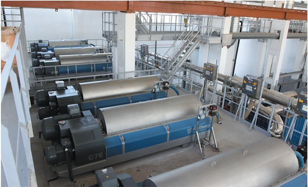
Рис. 2. Декантирующие центрифуги на Люберецких очистных сооружениях
